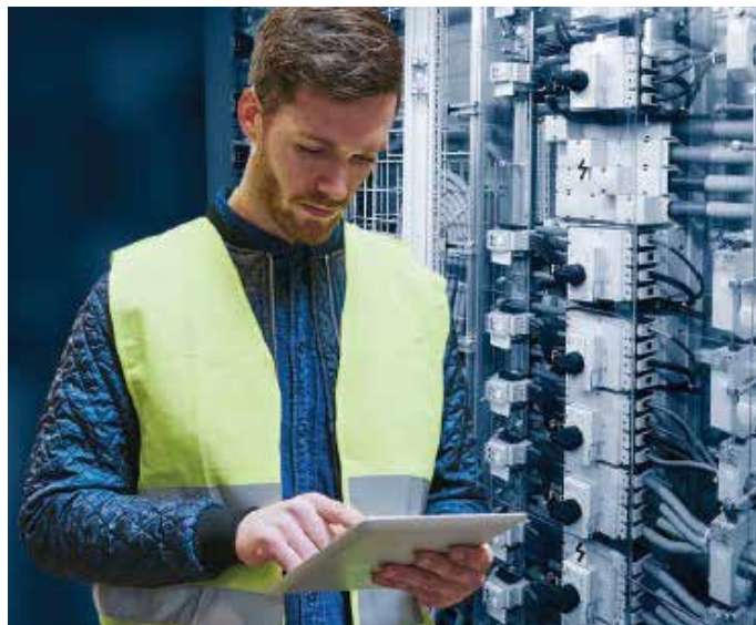
Figure 4 : En cas d'intervention sur un équipement, le disjoncteur électronique NZM passe en mode maintenance pour une sécurité accrue.
